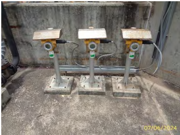
ภาพที่ 2.2-1 Gas Detector
