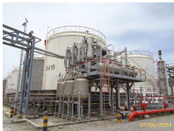
ภาพที่ 2.2-8 Vent Condensing Unit
