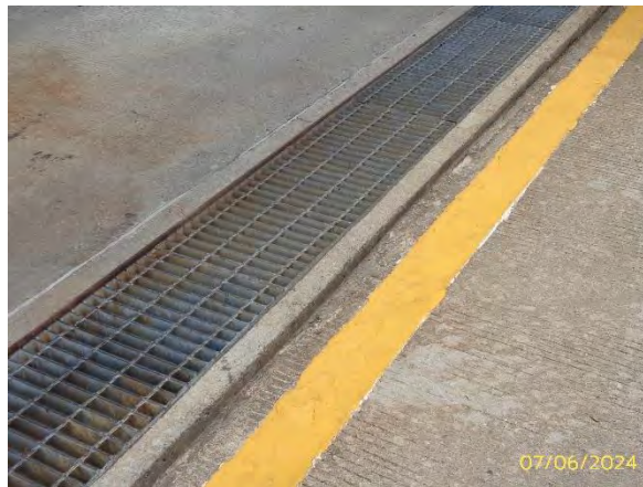
ภาพที่ 2.2-15 รางรองรับสารเคมีเมื่อเกิดการรั่วไหล
