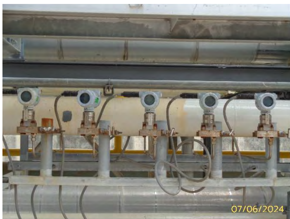
ภาพที่ 2.2-7 Pressure Transmitter
