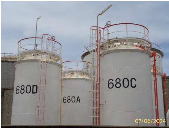
ภาพที่ 2.2-17 ถังรองรับน้ำอับเฉา
