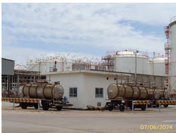
ภาพที่ 2.2-11 การเตรียม Pre-Pumping เพื่อรวบรวมน้ำที่ปนเปื้อนเคมีภัณฑ์ไปกำจัดภายนอก
