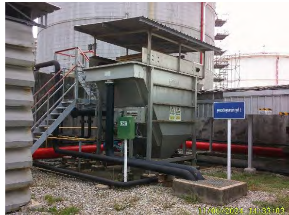
ภาพที่ 2.2-14 Oil-Water Separator
